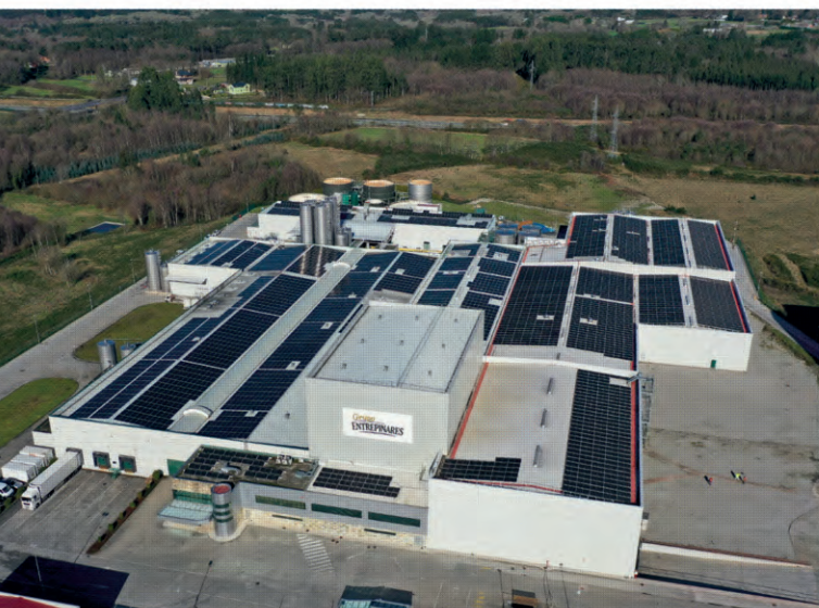
Instalación fotovoltaica sobre cubierta de 2.400 kW
