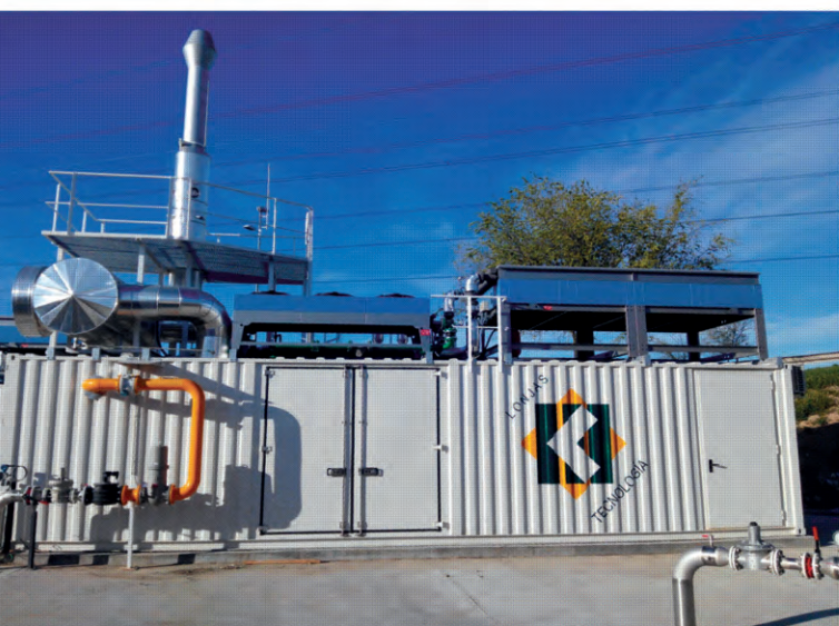
Módulo de cogeneración con biogás de 1.400 kW e
