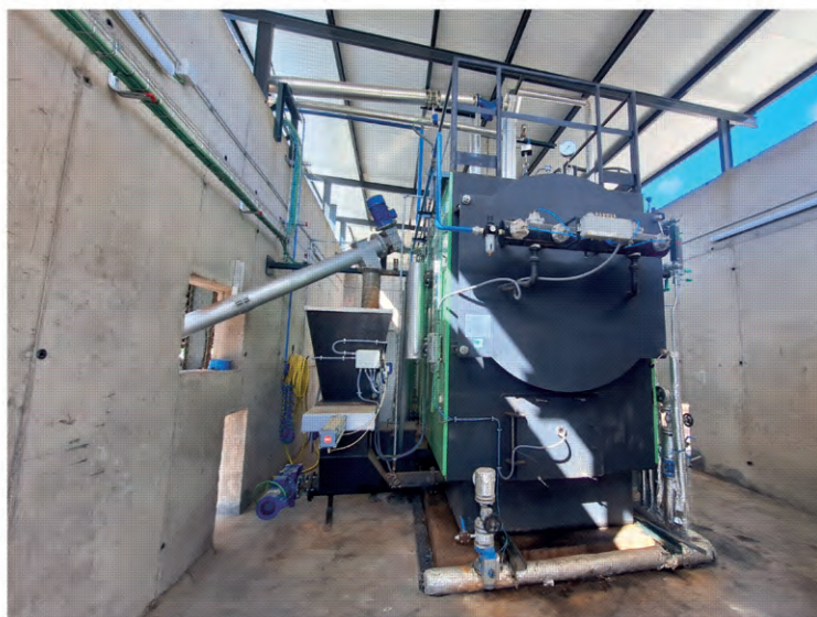
Caldera de biomasa para la generación de 1.500 kg/h de vapor
