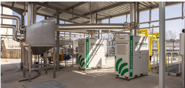
generación mediante 2 microturbinas de 65 kW y previsión de instalación de una tercera. Instalación ejecutada a la intemperie con un tejado de estructura metálica.
