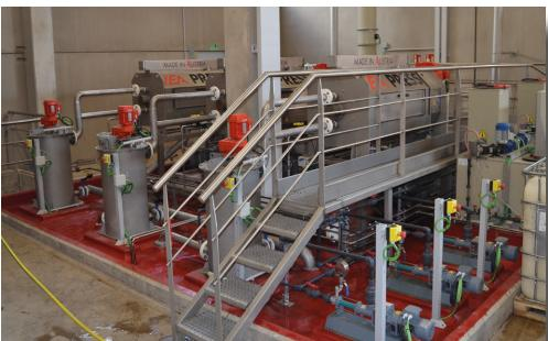
o Un sistema de dilución en continuo de polielectrolito, compuesto por una cuba de 2 m<sup>3</sup> de volumen unitario, dos electroagitadores, un dosificador volumétrico y un cuadro de control y mando.
