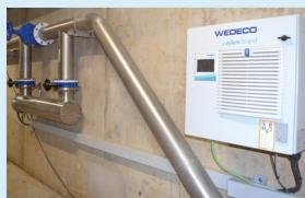
**- Wedeco UV LBX 120E:** Reactor de desinfección UV de la serie LBX de Xylem, especialmente eficiente para aguas residuales, reutilización, aguas superficiales y procesos industriales, que incluye tecnología OptiDose™ de control automático, que optimiza la dosis UV según calidad y caudal, reduciendo el consumo energético hasta un 20 % y cuenta con sistema de limpieza automática de mangas para mantener la transmitancia y eficiencia del sistema.
