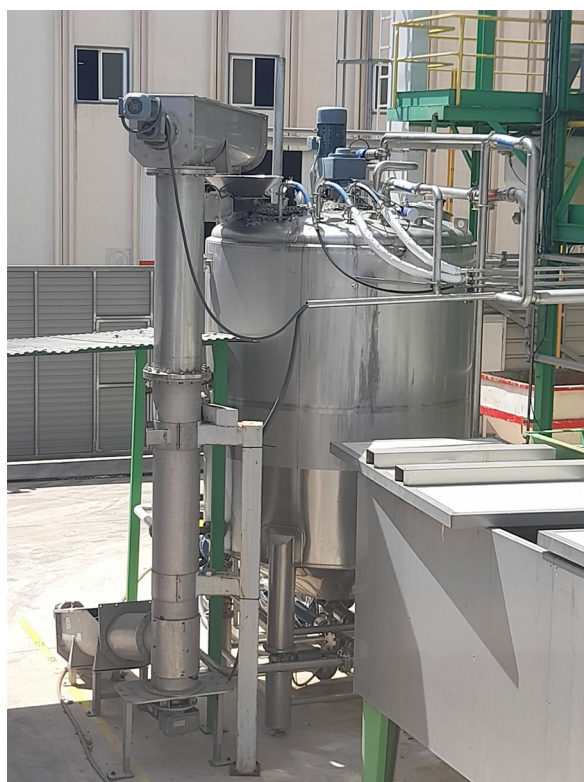
FIGURA 6. Reactor de 10 m 3 del pretratamiento del papel
