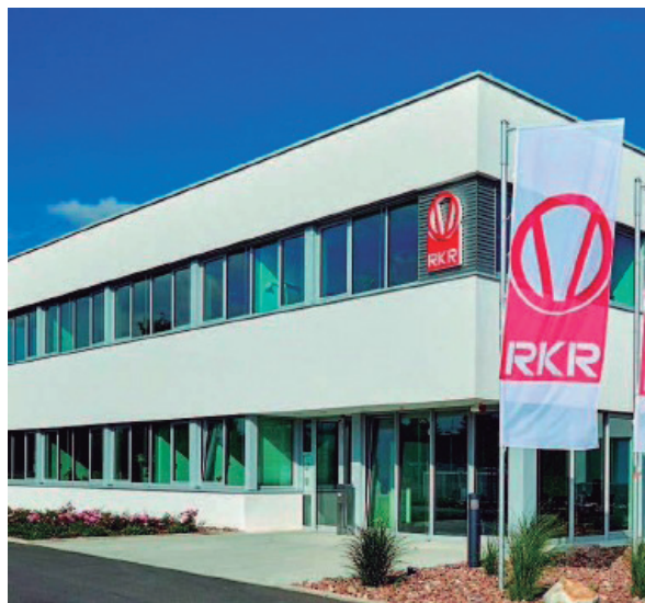
RKR, centro de competencia en biogás del Grupo AERZEN, desarrolla sistemas a medida sobre tecnología de soplantes y compresores de alto rendimiento.
