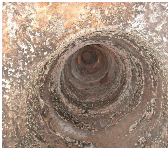
Sobre estas líneas, Zarza para ventilación. A la izquierda, bodega sótano. Fuente de las fotos: Proyecto Cowinergy
