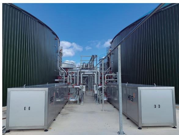
Los intercambiadores de calor de la Serie HRS DTI son muy eficientes para calentar el digestor.
