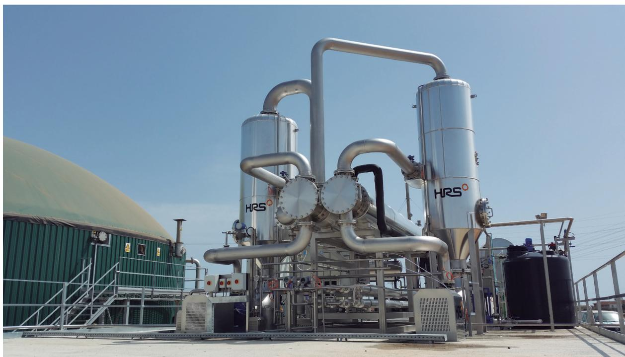
El Sistema de Concentración de Digestato (DCS) de HRS ayuda a reducir las emisiones de amoníaco asociadas con el digestato. A la izquierda, el Sistema de Deshumidificación de Biogás (BDS) de HRS prolonga la vida útil de los equipos y mejora la eficiencia de la planta.
