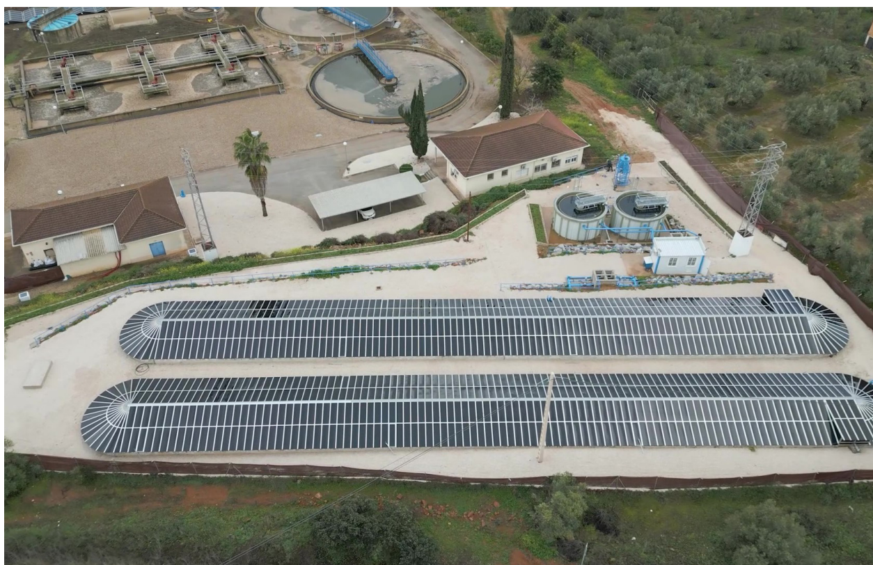
Vista de pájaro de la fotobiorrefinería PPB en la EDAR Linares. AUTOR: Francisco Javier Delgado Puerto Bird's-eye-view of the PPB photobiorefinery at the Linares WWTP. AUTOR/PHOTO BY: Francisco Javier Delgado Puerto
